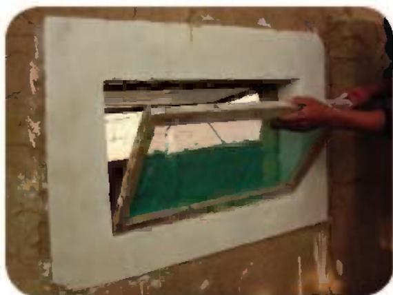
Para evitar el ingreso de plagas a los invernaderos, es necesario que en las construcciones se considere el uso de mallas o bastidores para ser colocados en las puertas y ventanas.
