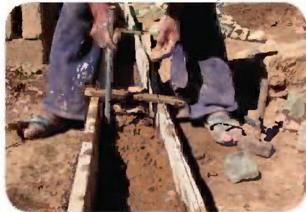
**12** La distribución del barro se debe realizar de forma permanente para obtener una capa uniforme.
