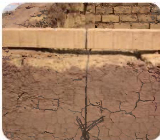
**8** El listón quedara completamente sujetado. La sujeción se realizara en ambos muros y por lo menos en 5 sitios diferentes.
