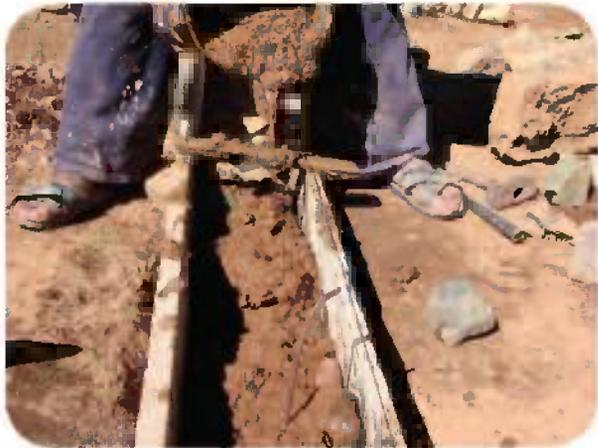
**9** El barro se extiende de forma uniforme por todo el encofrado.
