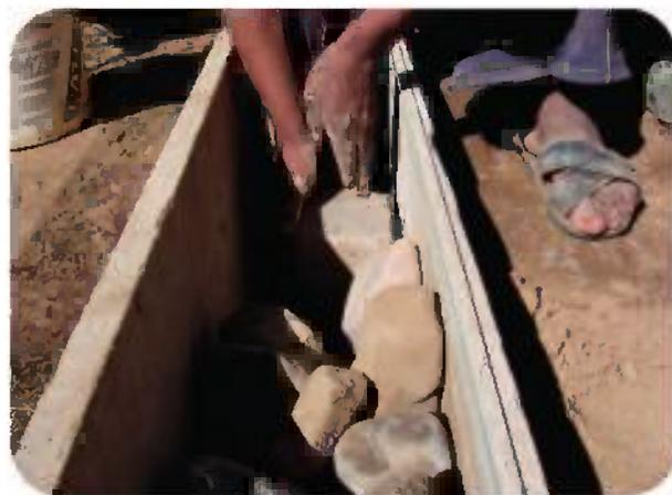
**6** El colocado de piedras será uniforme y compacto para poder resistir el peso de los muros o paredes.
