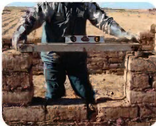
**2** Se nivela correctamente y se sujeta con barro para continuar la construcción de la pared.
