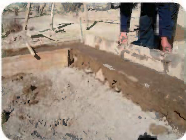
**15** Después de dos días de fraguado o secado del **sobre** cimiento, se retiran las maderas, evitando causar daños.
