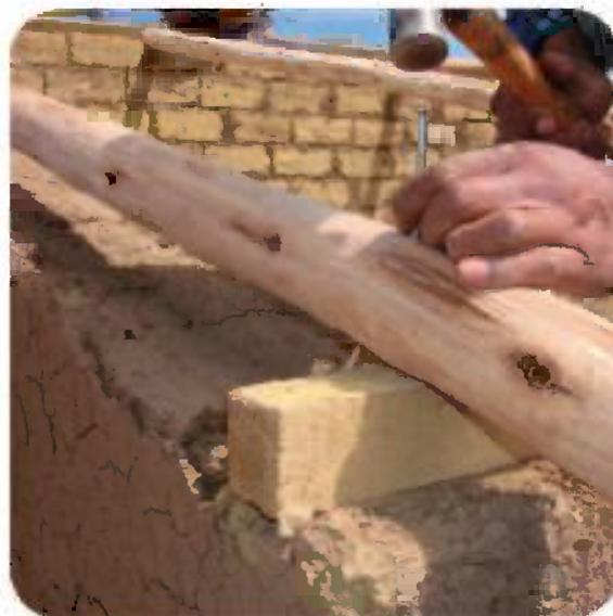
**5** Sujeción de los rollizos sobre el listón utilizando clavos.
