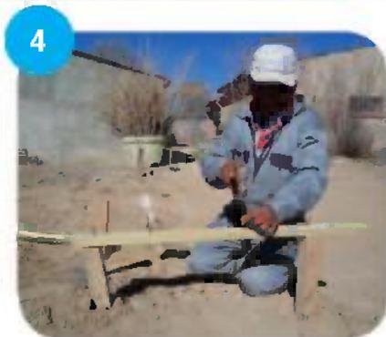
Colocado de clavos con la arista interior y exterior del muro, entre clavo y clavo se medirá la fundación.
