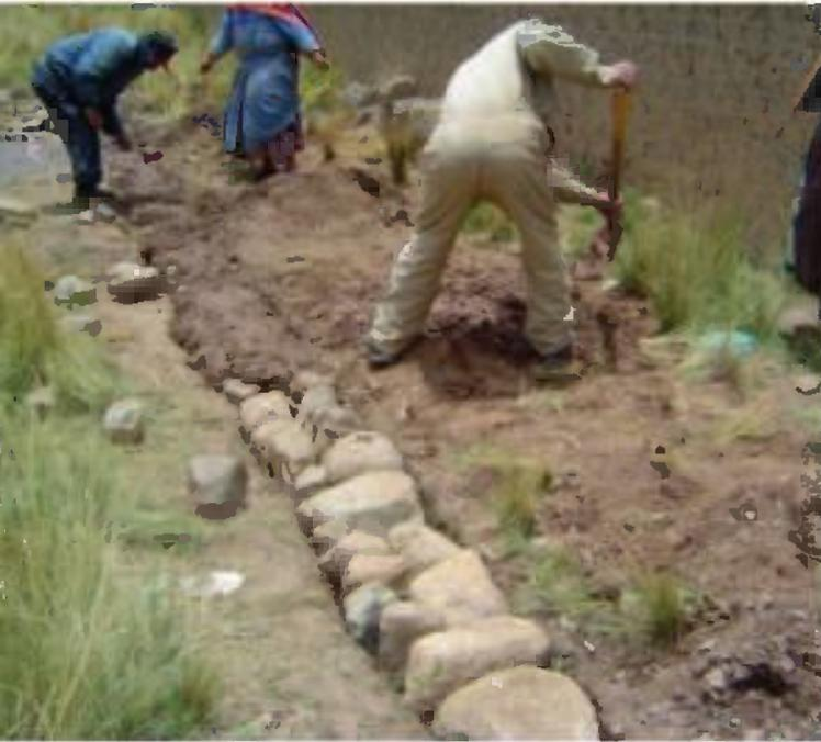
Los cimientos o fundaciones son el soporte de la construcción, es la parte inferior de los muros, se encuentran en contacto con el suelo.
