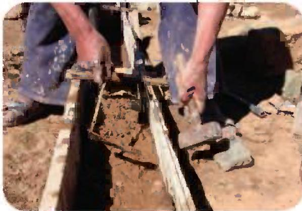
**11** Considerando que no se utilizará cemento, compactar la piedra con la ayuda de un combo, se obtiene mejor resistencia.
