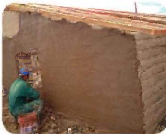
**4** Afinado con agua y muro revestido con barro.
