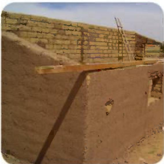
**1** El soporte de los rollizos o callapos será un listón lateral, el cual debe colocarse en la parte baja, sujetado con alambre de amarre.
