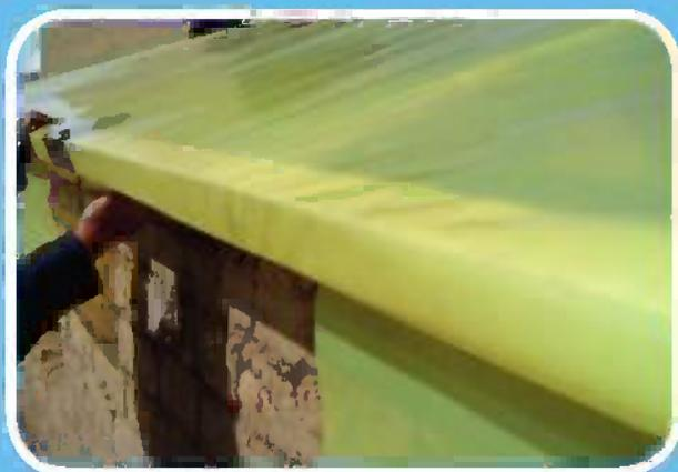
El tesado del agrofilm requiere que éste sea acomodado y fijado con clavos en la parte externa, para luego jalarlo suavemente desde la parte interna del invernadero. Cuando el proceso de dilatación al sol se ha realizado de forma correcta, no es necesario tesar demasiado. Internamente se sujeta también con clavos y arandelas de goma. esta última parte será cubierta con barro.
