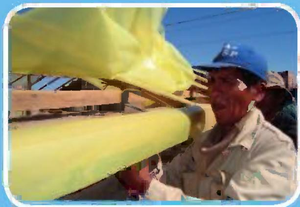
El techado se realiza en días con mucho sol. El agrofilm antes del fijado debe ser tesado, extendiéndolo en el armado de madera o bastidor, por un tiempo aproximado de 1 hora con luz directa del sol.
