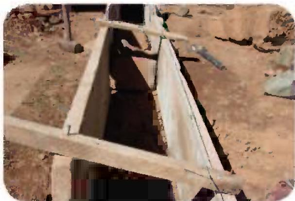
**3** El encofrado o encajonado debe estar nivelado y firme para resistir el **peso** de las piedras y el barro, el **mismo** se inicia a nivel del suelo y encima del cimiento.
