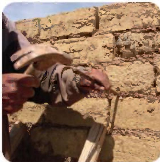
**2** Se perfora la pared para el sujetado con alambre.
