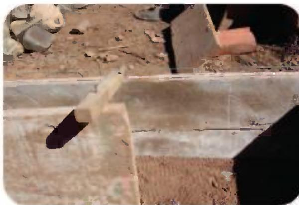
**2** El encofrado del sobre cimiento se arma encima del cimiento. Se recomienda que el encofrado tenga 30 cm. de alto y un ancho conforme al tamaño del adobe que será utilizado.
