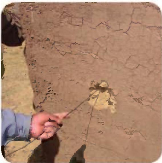
**5** En la pared previamente agujerada se introduce el alambre que sujetara el listón.
