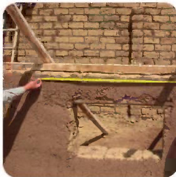
**1** Distribución de los rollizos o callapos. A 1m. de distancia entre callapos y encima de los listones de ambos muros.
