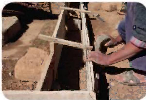
**4** También deberá estar sujetado, con madera, clavos y **alambre**. El ancho igual al tamaño de adobe que se utilizará en la construcción de las paredes.
