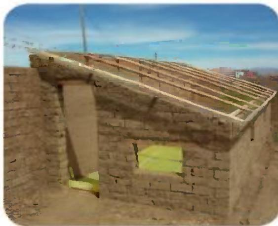
**11** Bastidor terminado para el colocado del agrofilm.
